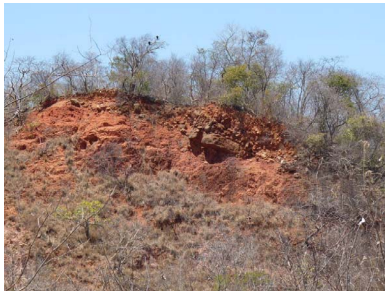
Foto 4.6 - Contato discordante entre depósitos coluvionares e Formação Missão Velha (km 45+900) na região do emboque do Sifão Boqueirão
