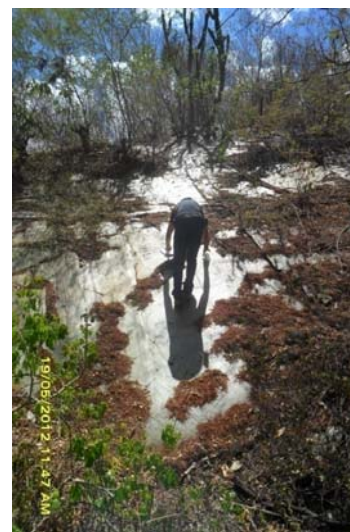
Foto 3.4 - Lote 1: Rugosidade lisa em filitos no sifão BR-116 (1)
