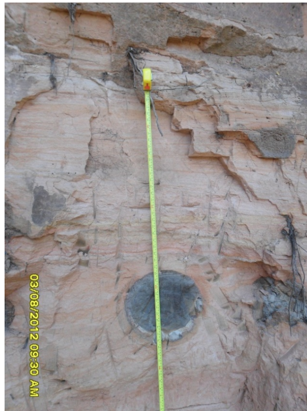
Foto 4.3- Encosta vertical próximo ao emboque do Túnel Sitio Alto I.
