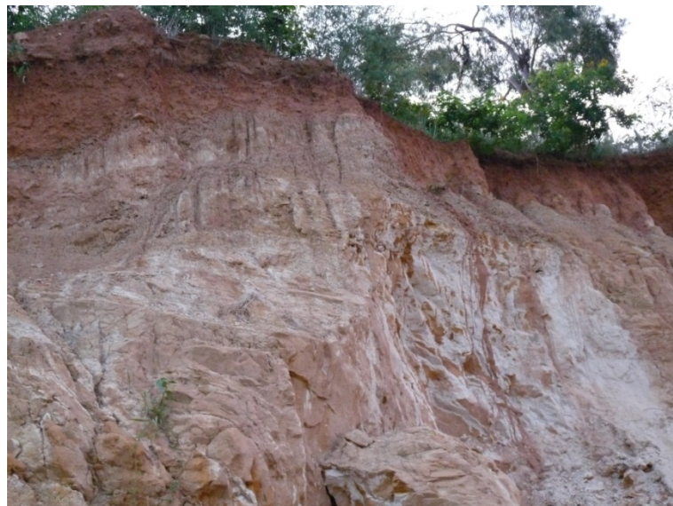
Foto 7.10 -Encosta subvertical na região do emboque do túnel Boa Vista
