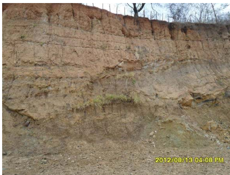
Foto 6.1 - Lote 3, região do Emboque do Túnel Boa Vista (km 111+215), mostrando estruturas de acanalamento – Corte de Jazida da iniciativa privada de empresas da região do Crato/CE.
