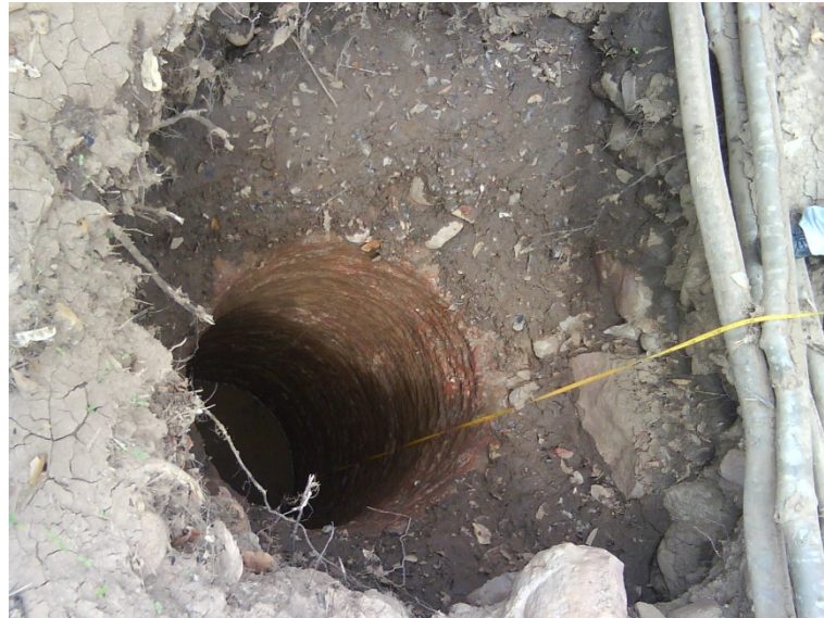
Foto 7.1: Poço profundo emboque Sítio Alto 2 com horizontes de colúvio e solo residual
