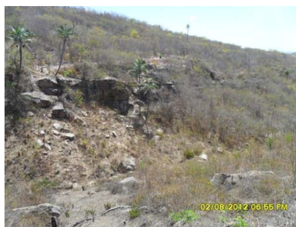
Foto 3.12 – Encosta de elevada inclinação próxima na estaca 16+500
