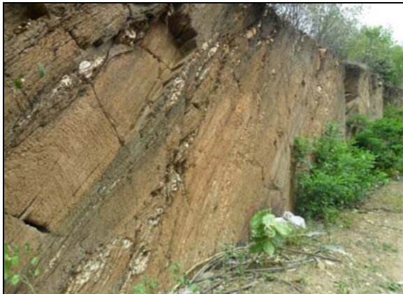
Foto 3.1 - Corte em micaxisto e filito, localizado próximo do estaqueamento 1+200
