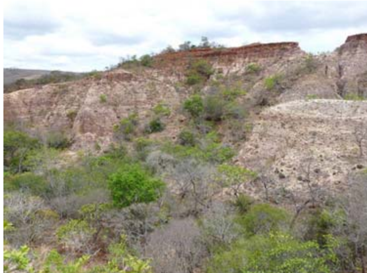
Foto 4.2- Encostas abruptas em arenitos próximo ao Túnel Sitio Alto 2
