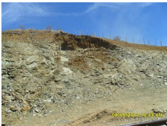
Foto 3.3 - Escorregamento de solo residual e rocha extremadamente alterada na Transnordestina.
