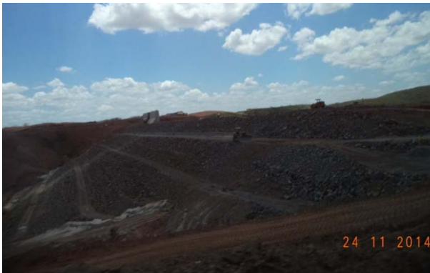
Foto 1 - Barragem de Jati em construção
