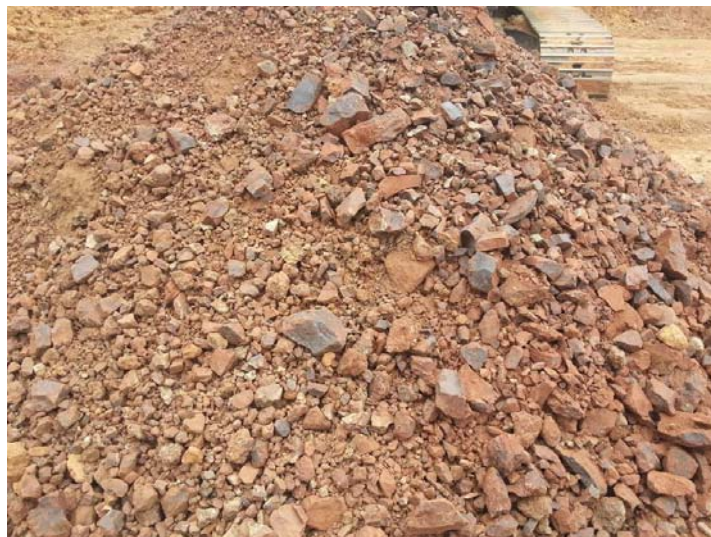
Foto 3.7 - Lote 1: Vista argilito escavado da Formação Brejo Santo
