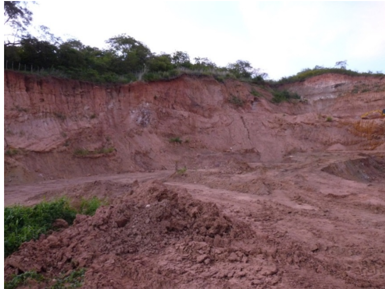
Foto 7.9: Vista geral da escavação do emboque do túnel Boa Vista
