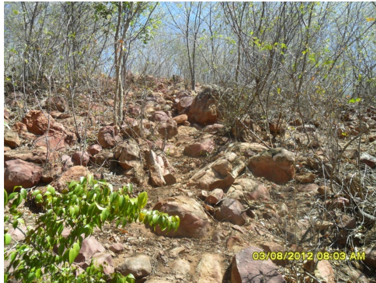
Foto 4.5 - Lote 2: Blocos de arenito soltos e envolvidos por solo coluvionar no km 38+600
